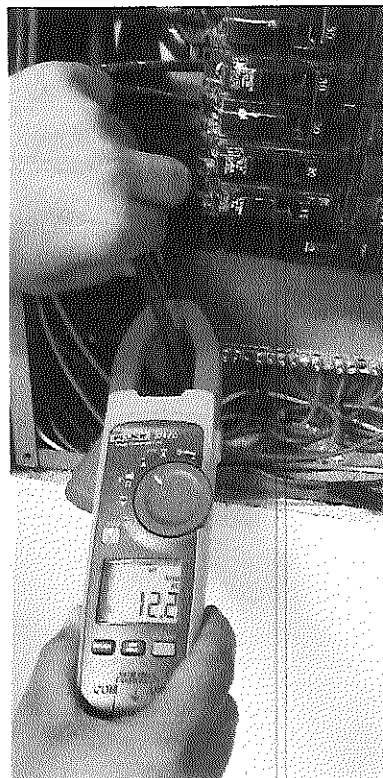
Medición de la corriente de la fase B.
